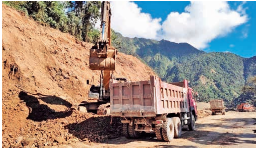
La construcción de la doble vía El Sillar. ABC
