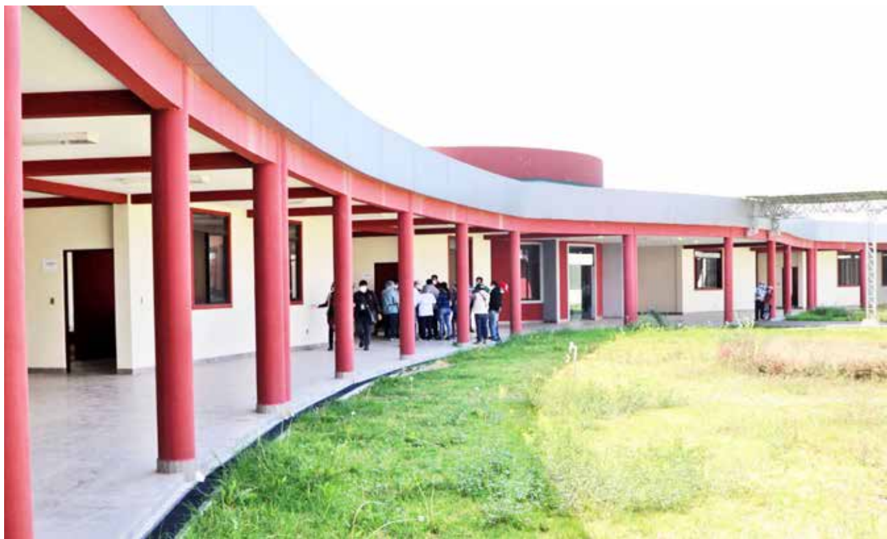
El centro de aislamiento en Illataco, en Quillacollo. AXX
