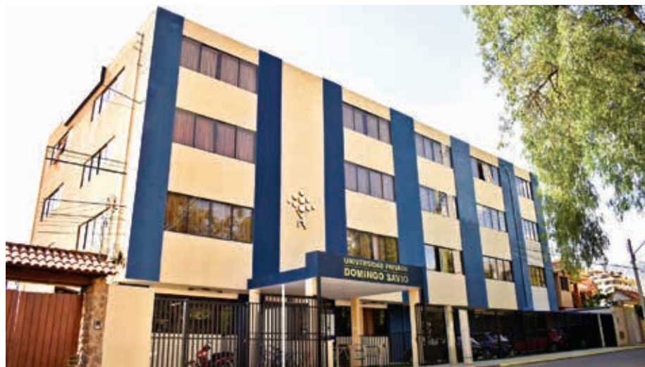
Ambientes. Edificio académico de la UPDS, en Cochabamba.
